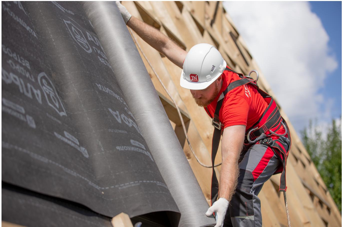
Далее мембрану фиксируют контрбрусом, который также служит для создания вентканалов, на контрбрус монтируется разреженная обрешетка. Между мембраной и бруском необходимо уложить уплотнительную ленту АЛЬФА КОНТРБРУС.
