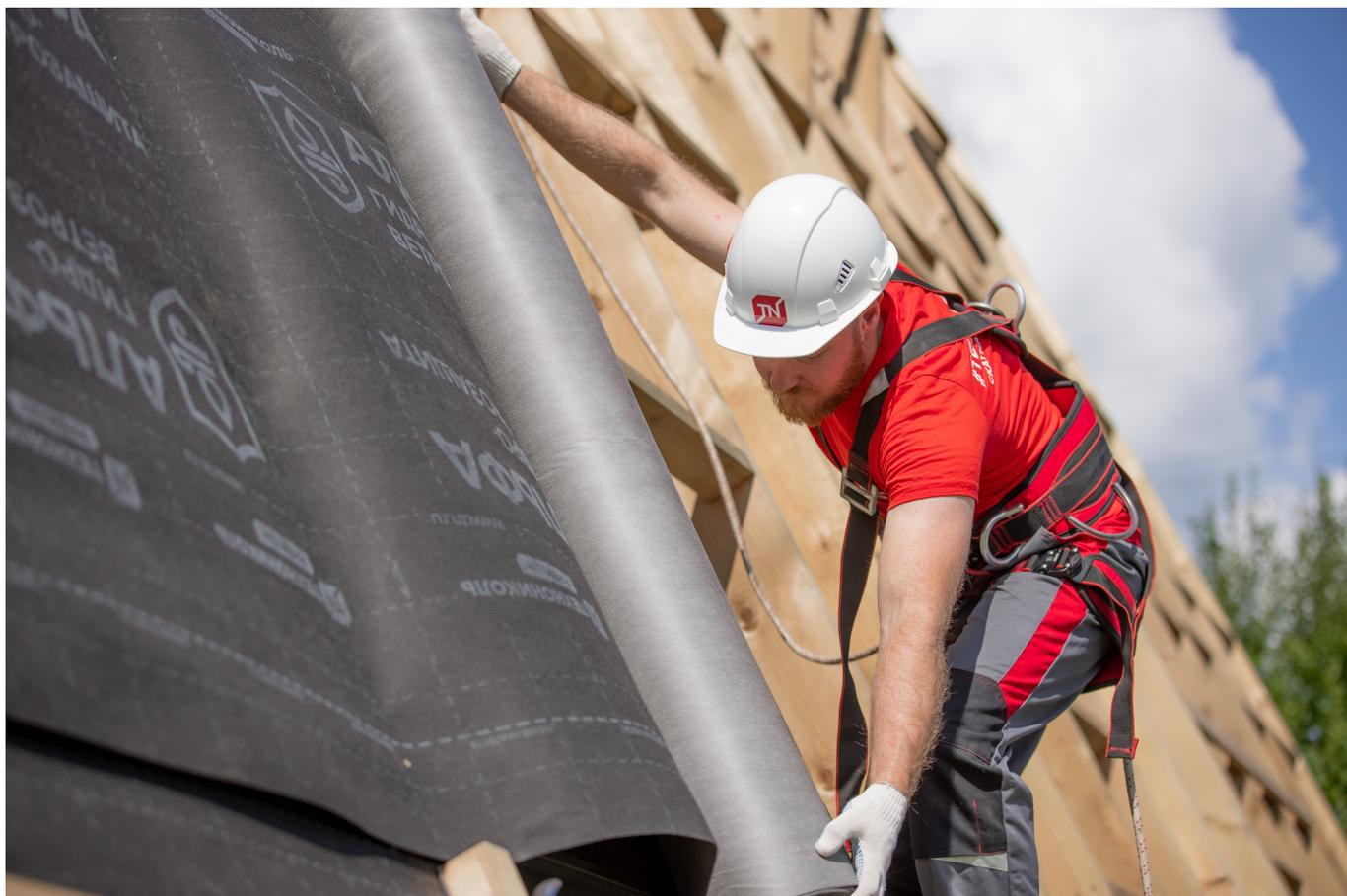
Далее мембрану фиксируют контрбрусом, который также служит для создания вентканалов, на контрбрус монтируется разреженная обрешетка. Между мембраной и брусом необходимо уложить уплотнительную ленту АЛЬФА КОНТРБРУС.
