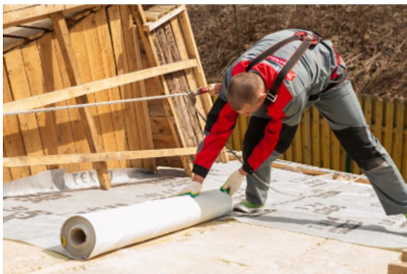
Гидро-ветрозащитный слой защищает деревянный каркас и слои теплоизоляции от солнечного и ветрового воздействия, попадания влаги (дождь, снег) и помогает выводить пар из утеплителя.
