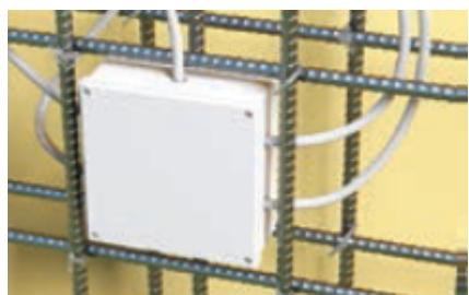
Если инъекционные трубы выводятся напрямую без применения распределительных коробок, то они обязательно должны быть защищены от механического повреждения и засорения строительным мусором и бетонной смесью. Следует предусмотреть защиту трубок как вовремя укладки бетонной смеси, так и после ее отверждения. Для этого трубы можно «подвязать» к заранее установленной арматуре или смонтировать защитный короб из пиломатериалов или оцинкованной стали.
