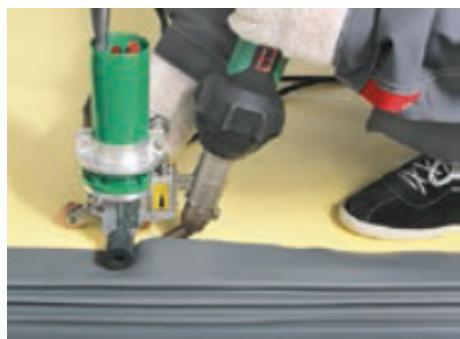
Прилагая необходимое усилие к рукоятке аппарата, плавно ведите аппарат вдоль шва. Следите за тем, чтобы края гидрошпонки равномерно приваривались к поверхности мембранны.
