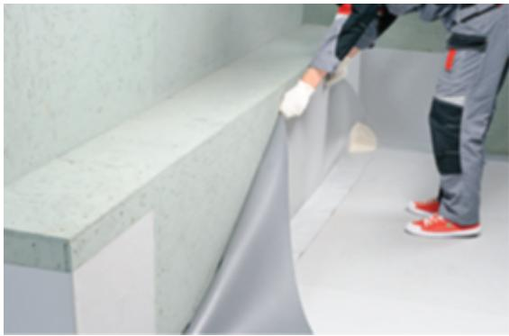
Если высота заведения мембранны на парапет составляет более **450 мм** либо нужно сделать парапет со слоем доутепления, используйте для крепления дополнительный скрытый карман с рейкой.
