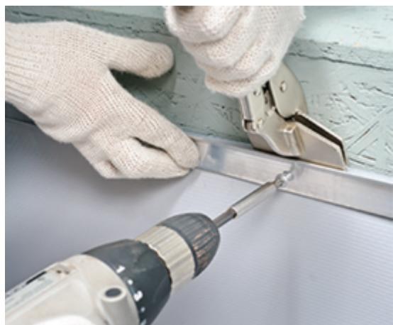
Для крепления краевой рейки к парапету, выполненный из сэндвич-панели, необходимо применять крепеж с толщиной наката не менее **5,5 мм**. Для выполнения примыкания к парапету при помощи ПВХ металла нарежьте планки шириной 50 мм при помощи ручных или электрических ножниц по металлу. Также можно использовать готовые ПВХ планки.
