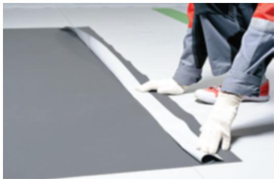
Вставьте прижимную рейку в «скрытый карман» и натяните мембрану «кармана» с помощью «зажима кровельщика», одновременно давя на рейку плоскогубцами. При креплении подкладывайте под крепеж металлическую пластину, чтобы избежать повреждения мембранны.
