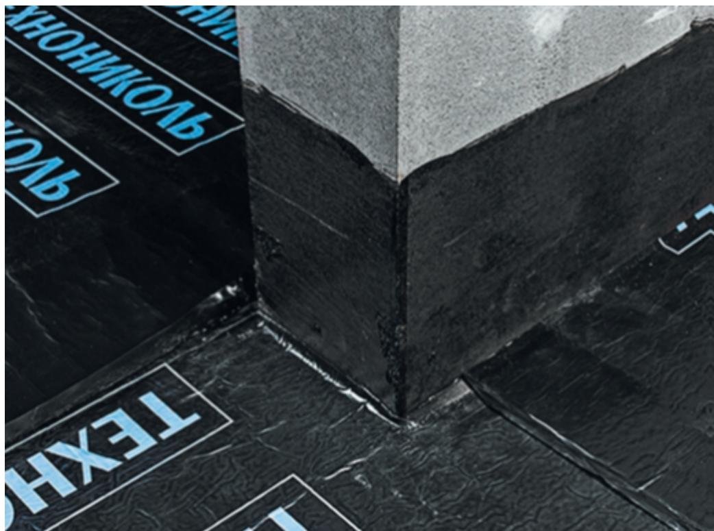
Приклейте материал с двух сторон вертикальной конструкции (стена, перегородка) на высоту не менее 200 мм.
