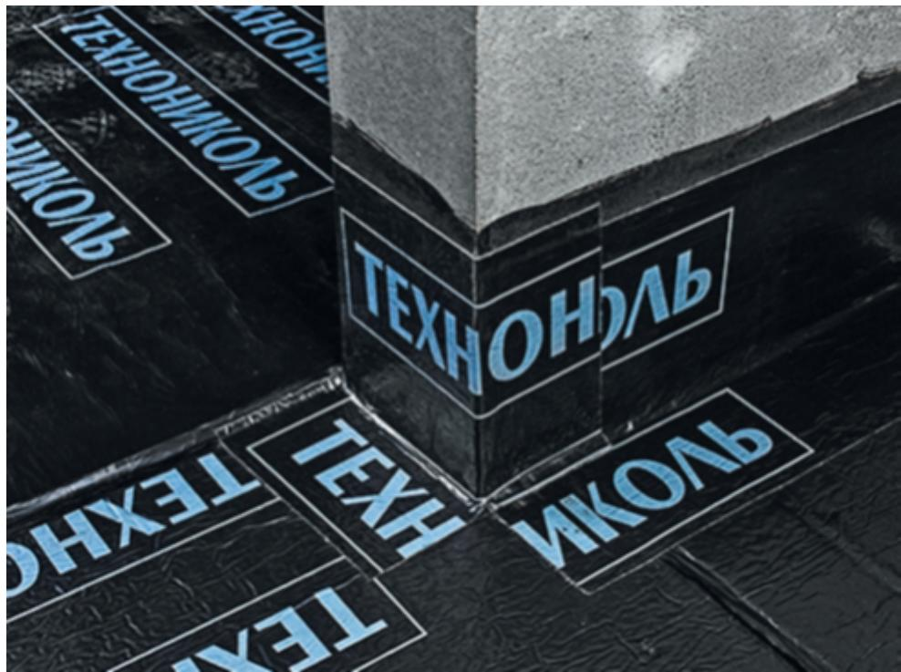
Для дополнительной герметизации приклейте заплатку в место сопряжения угла стены (перегородки) и горизонтального основания.
