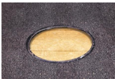
Если кровля выполняется по цементно-песчаным стяжкам, то прорежьте отверстие до уклонообразующего слоя. Диаметр отверстия должен быть равен внутреннему диаметру трубы аэратора.
