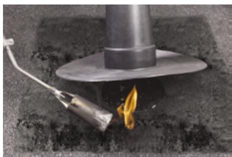
Следите за равномерным вытеком битумно-полимерного вяжущего из-под юбки уплотнителя. Вытек обеспечивает полную герметичность соединения.
