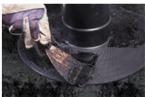
Подготовьте и наплавьте слой усиления. Слой усиления должен перекрывать фланец аэратора на 150 мм.
