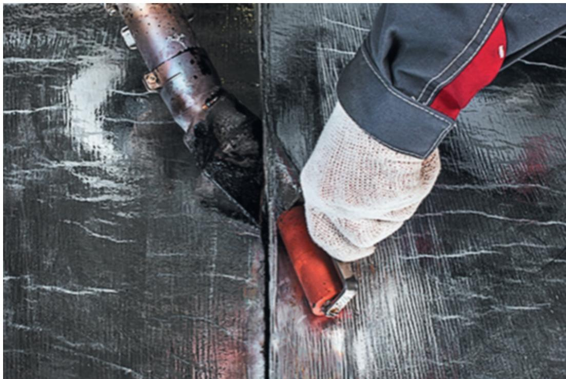
Следите за тем, чтобы из-под кромки шва был небольшой вытек. Вытек свидетельствует о герметичности шва.
