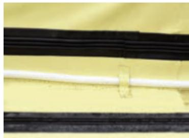
Компенсатор напряжений из экструзионного пенополистирола выполнять в виде бруса 50x50 мм. Крепление компенсатора напряжений к поверхности полимерной мембраны осуществлять при помощи предварительно приготовленных полосок из применяемой полимерной мембраны с последующей приваркой их к поверхности гидроизоляционного покрытия.
