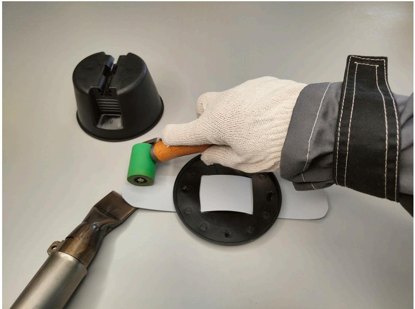
Одеваем верхнюю часть держателя провода-молниеотвода, держатель установлен.
