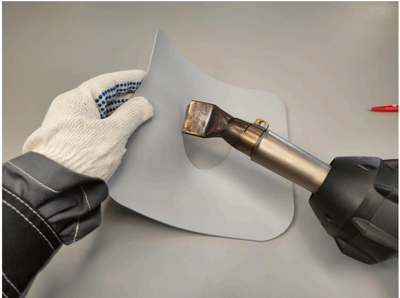
Продеваем мембрану сквозь держатель провода-молниеотвода, пока она еще не остыла.
