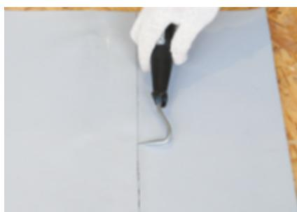
Для проверки качества сварки проведите пробником вдоль шва, легко нажимая на него – кончик пробника не должен проникать в шов.
