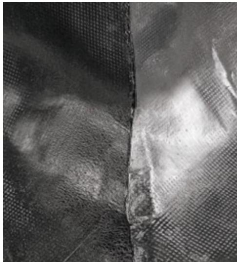
Затем наплавьте второй слой гидроизоляционной мембраны по всему периметру фундаментной плиты.
