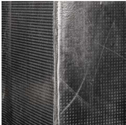
Затем выполните наплавление второго слоя гидроизоляционной мембраны на вертикальных ограждающих конструкциях по всему периметру сооружения.
