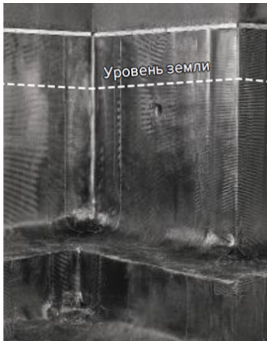
Верхний край гидроизоляционной мембранны закрепите к конструкции в цокольной части сооружения профилированной металлической краевой рейкой механическим путем.
