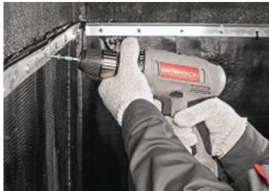
Зазор между стеной и отгибом краевой рейки заполните полиуретановым герметиком ТЕХНОНИКОЛЬ.
