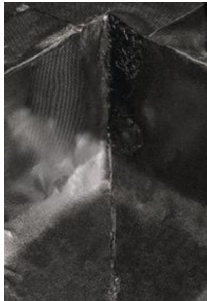
После этого выполните наплавление второго слоя гидроизоляционной мембраны в зоне внутреннего угла по вертикальным ограждающим конструкциям и наплавление второго слоя гидроизоляционной мембраны на вертикальных ограждающих конструкциях по всему периметру сооружения.
