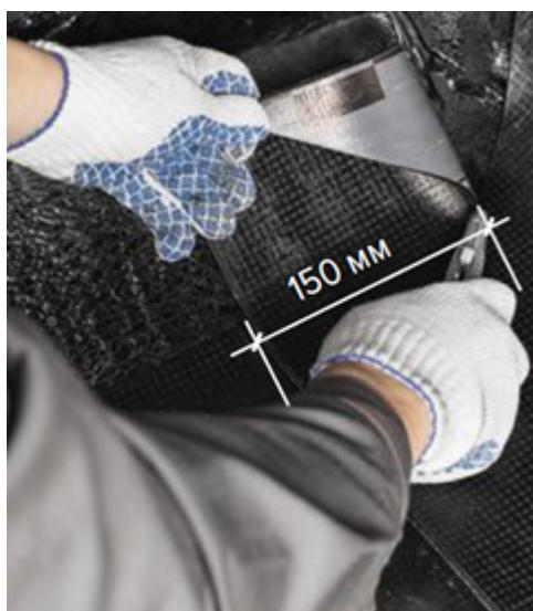
Скатайте материал в рулон и наплавьте его на конструкцию по направлению снизу вверх.
