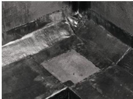
Примерьте и подрежьте заплатку по месту. Боковой нахлест на гидроизоляционную мембрану должен быть не менее 100 мм.
