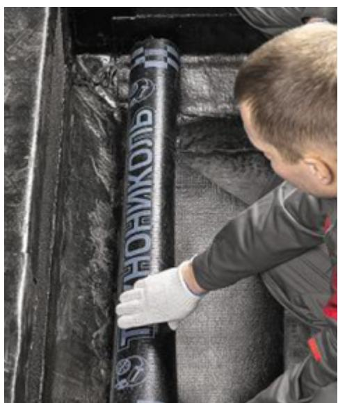
Начинайте наплавление на горизонтальной поверхности бетонной подготовки, постепенно раскатывая рулон вверх.
