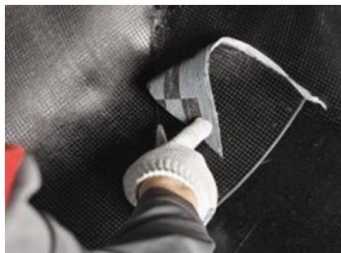
Наплавленные рулоны должны выглядеть следующим образом. После этого выполните наплавление первого слоя вертикальной гидроизоляционной мембраны на вертикальных ограждающих конструкциях по всему периметру сооружения.
