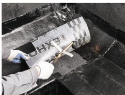
Наплавленная заплатка должна выглядеть следующим образом. После этого наплавьте рулоны первого слоя вертикальной гидроизоляционной мембраны на участке «бетонная подготовка — фундаментная плита» по всему периметру сооружения.
