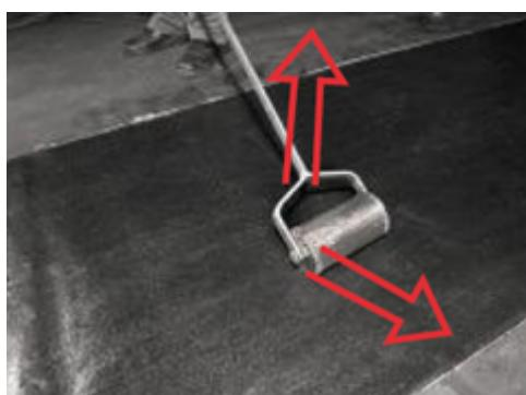
Одним из признаков герметичности сварного шва является вытекание битумной массы из-под боковой кромки материала сплошным валиком, примерно на 5÷25 мм.
