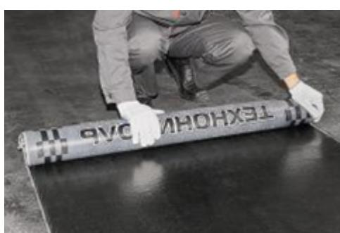
Наплавление производите, оплавляя нижнюю поверхность рулона пламенем горелки и одновременно подогревая поверхность основания. Нагрев производят плавными движениями горелки, уделяя особое внимание зонам нахлеста, постепенно раскатывая рулон на себя.
