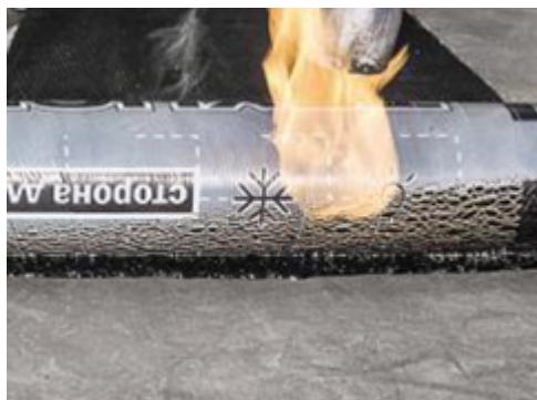
Наплавленные рулоны не должны иметь складок, морщин и волн. Для недопущения указанных дефектов прикатайте полотнища металлическим валиком, движения которого должны быть от оси рулона по диагонали к его краям, пока подложка размягчена. Особенно тщательно прикатайте зоны нахлестов.
