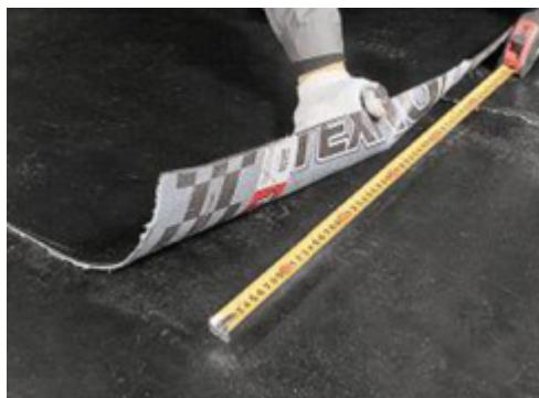
При наплавлении второго слоя также контролируйте соблюдение нахлестов: 100 мм краевой и 150 мм торцевой.
