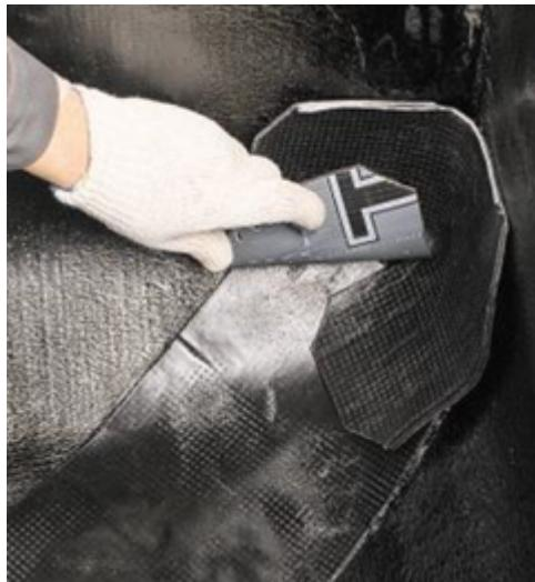
Тщательно наплавьте его. Подрезанные части наплавьте с нахлестом друг на друга.
