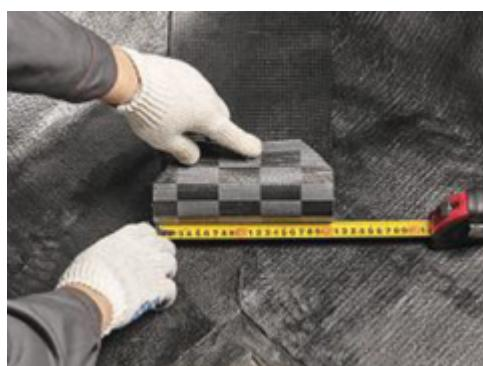
Примерьте и подрежьте элемент усиления на бетонной подготовке. Размер слоя усиления
