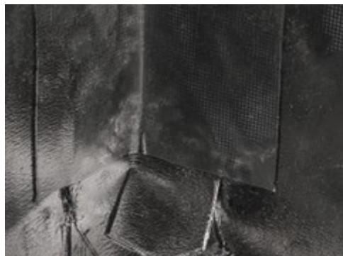
Общий вид внутреннего угла с первым слоем вертикальной гидроизоляционной мембраны и вторым слоем усиления.
