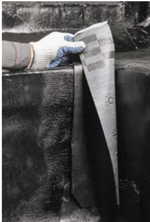
В верхней части фундаментной плиты подрежьте элемент усиления.
