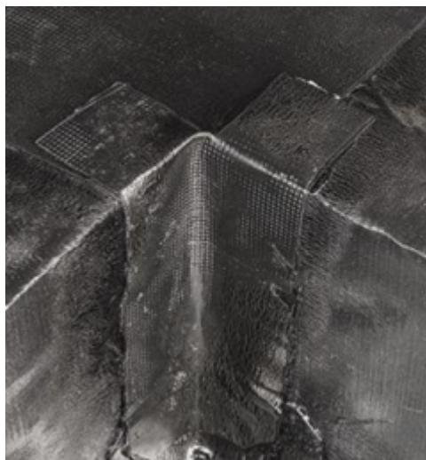
В верхней точке элемента усиления вырежьте и наплавьте пяточку.
