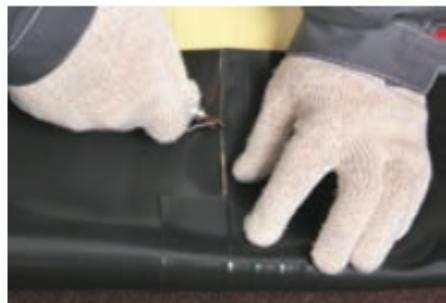
Проварите Т-образный шов автоматическим аппаратом. Усильте все Т-образные пересечения мембран, установив заплатки. Для этого вырежьте заготовку размером 120x120 мм из мембранны LOGICBASE V-SL.
