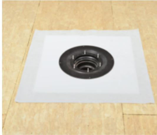
Для дополнительной герметизации нанесите ПУ герметик по внешнему контуру воронки и замажьте герметиком гайки.
