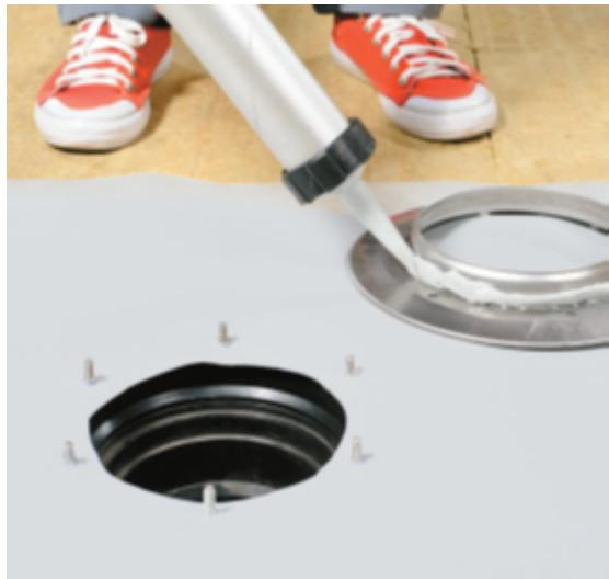
Прикрутите фланец гайками. Желательно получить выдавливание небольшого количества герметика из-под фланца после закручивания всех гаек.
