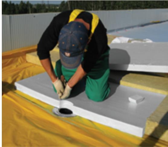
В случае использования одноуровневой воронки рекомендуется наклеить на пароизоляционную пленку бутил-каучуковую ленту по периметру листа усиления. Плиты XPS во время монтажа площадки плотно прижмите к ленте.
