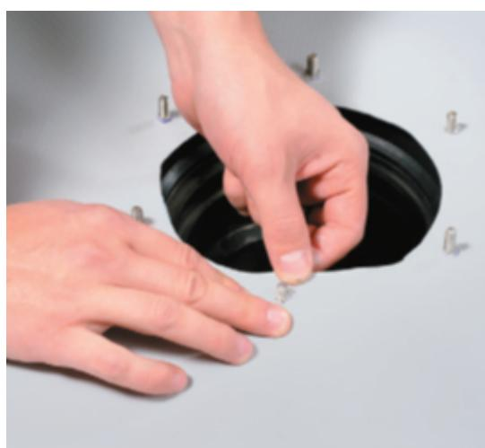
Для повышения надежности соединения нанесите ПУ герметик на внешний край воронки.
