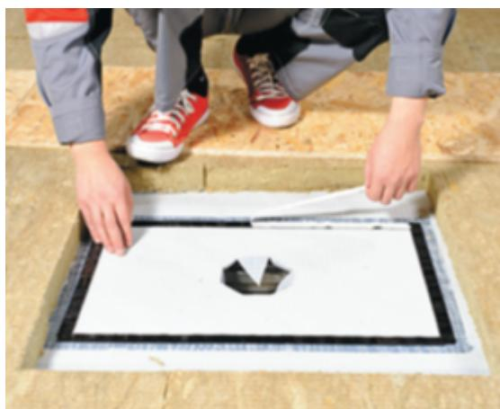
Сделайте в плитах отверстие для воронки. Для плотного прилегания фланца воронки «снимите» фаску, например, подплавляя XPS с помощью ручного фена.
