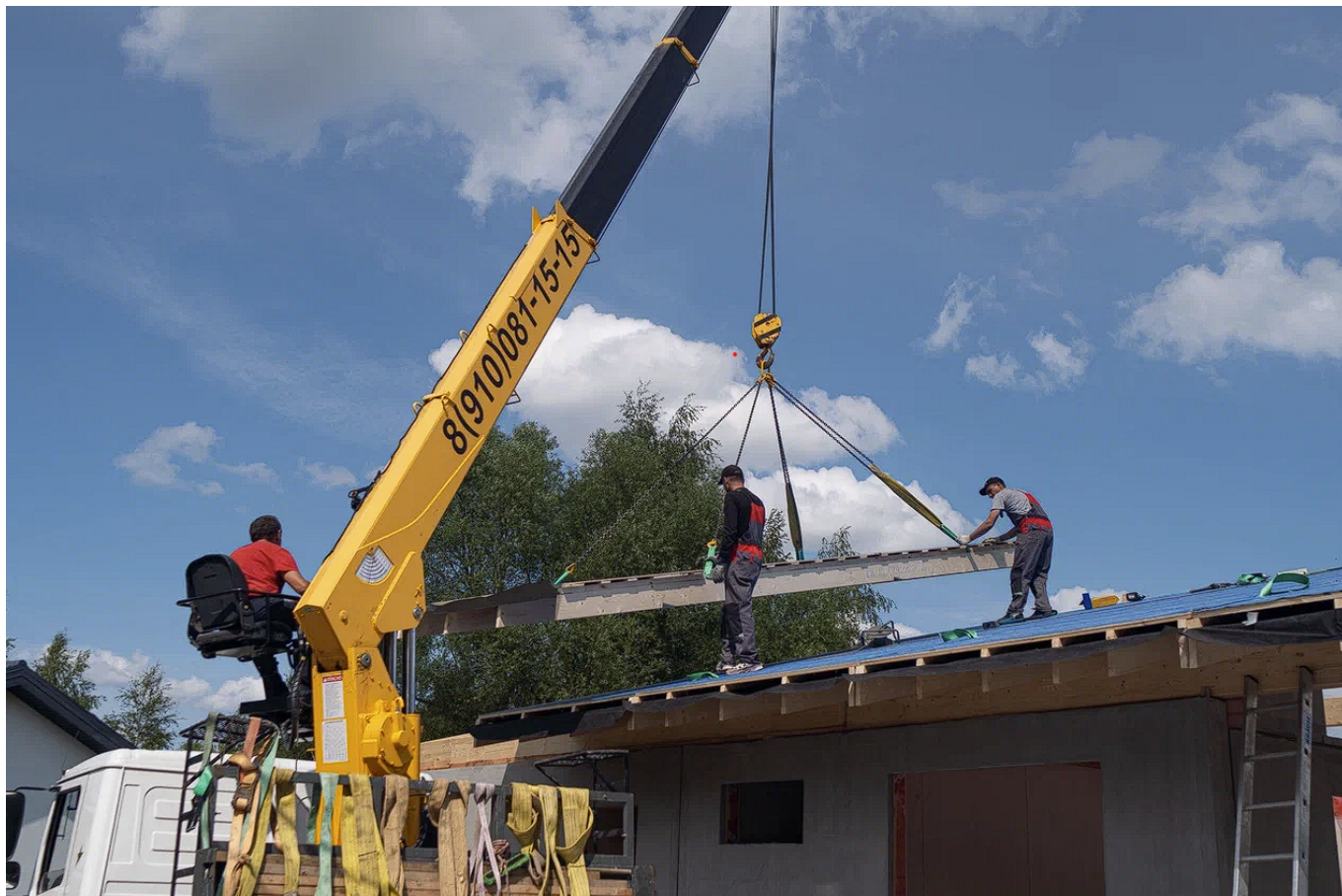
Рис.3. Монтаж кровельной панели при помощи специализированной техники
