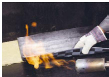
Для качественного наплавления материала на основание необходимо добиться небольшого валика битумно-полимерного вяжущего в месте соприкосновения материала с поверхностью.
