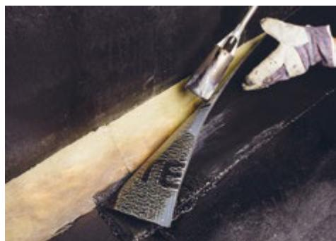
Признаком хорошего, правильного прогрева материала является вытекание битумно-полимерного вяжущего из-под боковой кромки материала от 10 мм до 25 мм.
