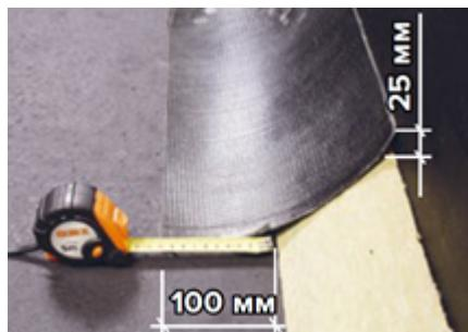
Торцевую часть рулона можно завести на наклонный бортик без устройства слоя усиления, при устройстве нижнего слоя водоизоляционного ковра методом наплавления. Это возможно только при подведении рулона к вертикальной конструкции торцевой частью: на вертикальную поверхность торцевая часть рулона должна заходить на 25 мм выше от наклонного бортика.
