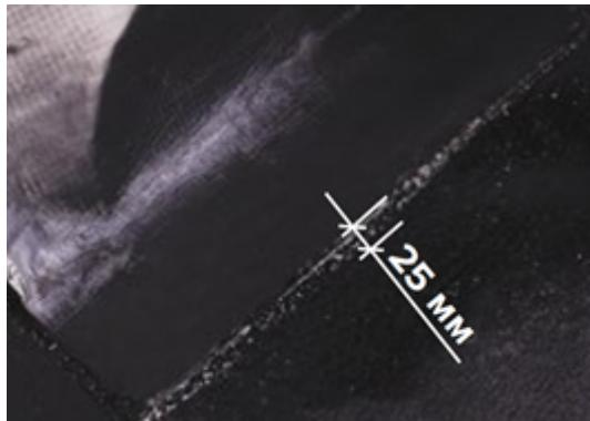
**Важно! Во избежания противошовки, укладку слоев усиления из материала Техноэласт ЭПП нужно начинать с пониженных участков кровли.**
