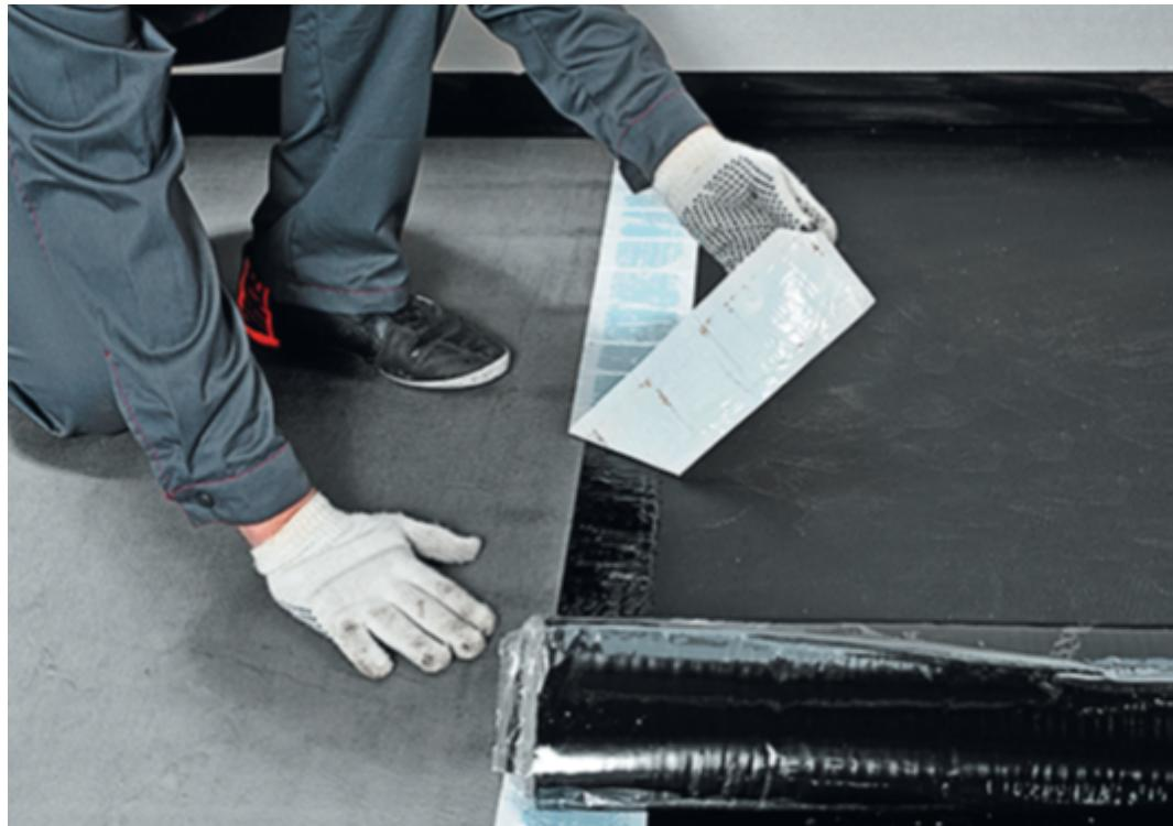
Торцевой нахлест смежных рулонов должен составлять 150 мм.
