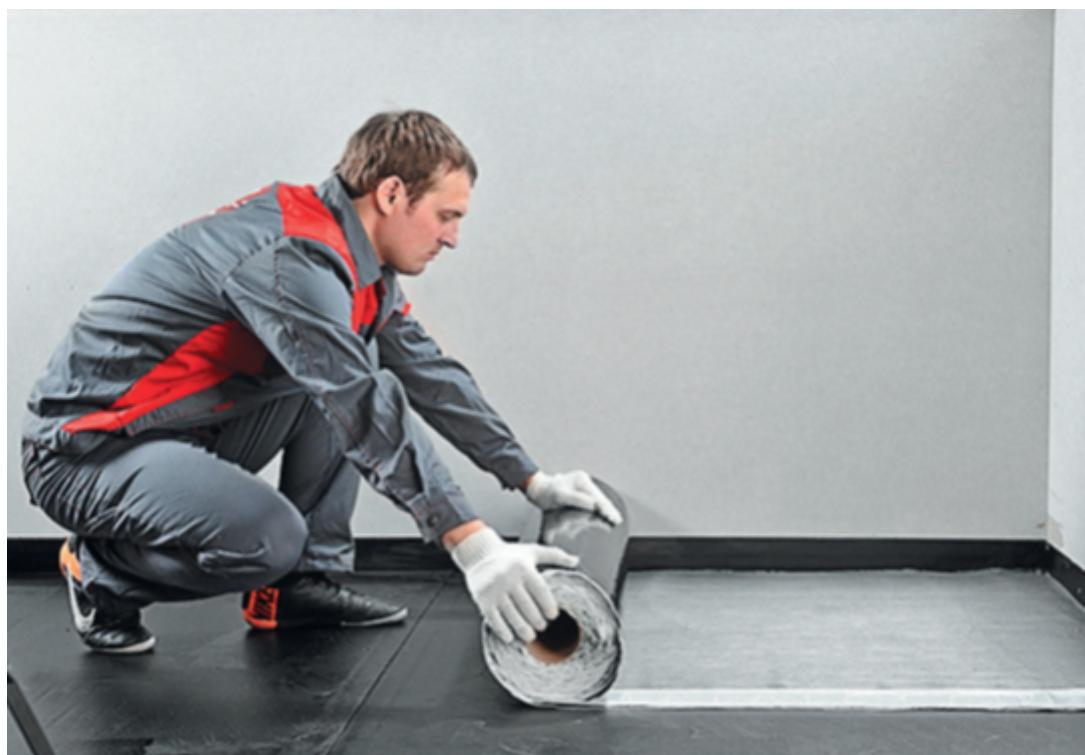
Рулон должен прилегать плотно к вертикальным поверхностям и прочим конструкциям.
