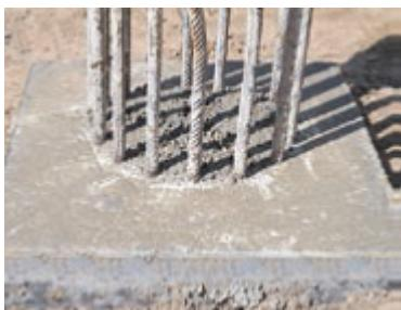
После твердения гидробетона демонтируйте опалубку.
