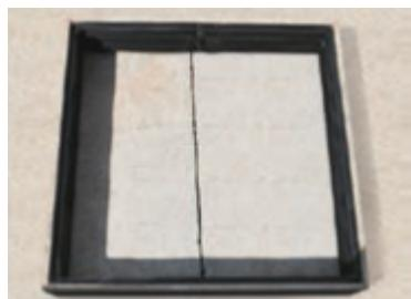
Установите гидрошпонку, закрепив ее плоской стороной к опалубке.
