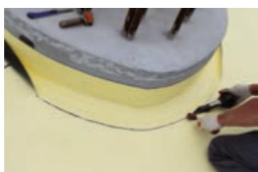
Такой способ примыкания к оголовкам свай требует тщательной подготовки основания для приклейки лент в части выравнивания и просушки.
