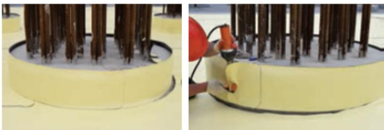
Сформируйте «отворот» нижнего края устанавливаемой полосы для формирования ее нахлеста на уже смонтированной по горизонтальной поверхности мембранны.
