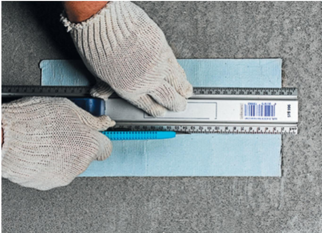
Надрежьте часть материала на лоскуты, которая пойдет на горизонтальную поверхность.
