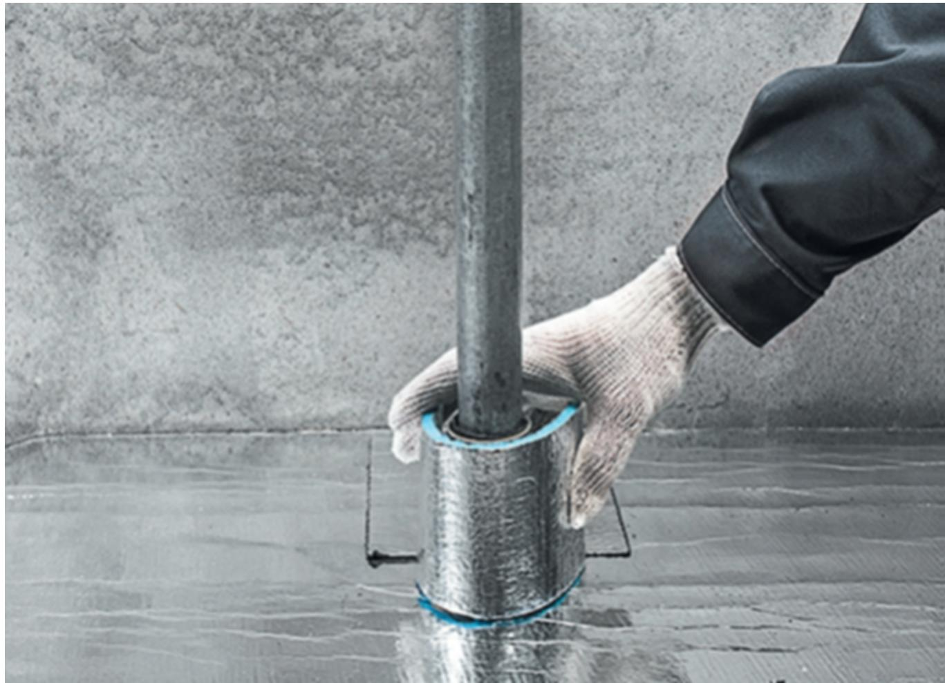
Обверните металлическую гильзу самоклеящейся демпферной лентой.
