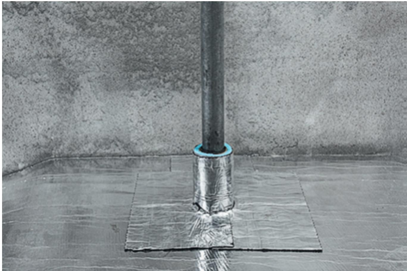
**ВАЖНО! Если вы делаете просто звукоизоляцию с помощью материала Звукоизоляция пола ТЕХНОНИКОЛЬ, тогда достаточно обвернуть демпферной лентой металлическую гильзу и все проклеить скотчем во избежание затекания раствора стяжки пола и развязки металлической трубы(и гильзы) от жесткого контакта с цементно- песчаной стяжкой(или другого типа).**
