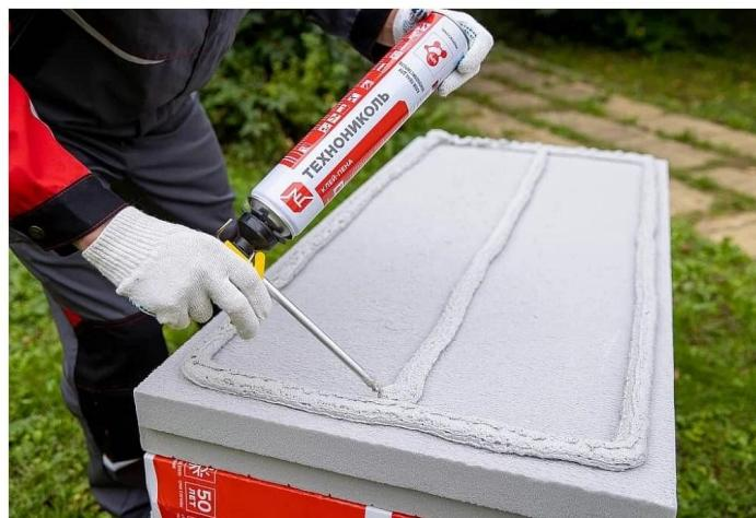
**Важно!** Перед началом работы встряхните баллон в течение 30 секунд, а после нанесения клей-пены дождитесь начала полимеризации в течение 5 минут и прижмите плиты теплоизоляции к основанию. В течение 15 минут можно корректировать положение, плавно смещающая плиты.
