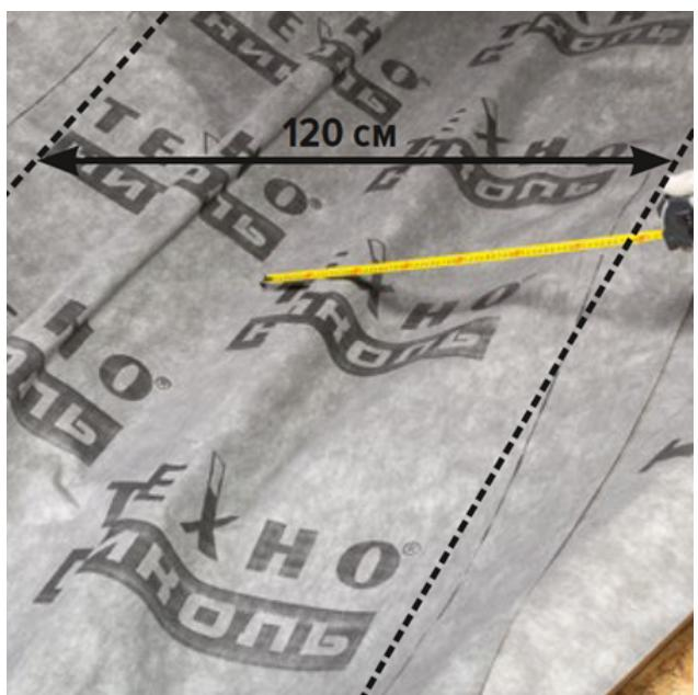
Нижний край стартового полотна пленки заведите на лобовую доску минимум на 2 см и зафиксируйте строительным степлером. Каждый следующий ряд пленки заводите на предыдущий с нахлестом в 15 см, по принципу каскадности воды.
