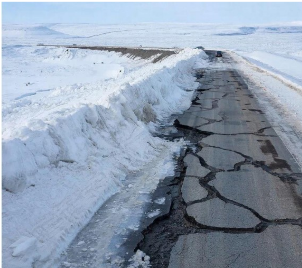
Рисунок 2. Проявления деформаций дорог на ММГ из-за неверного проектирования и эксплуатации
