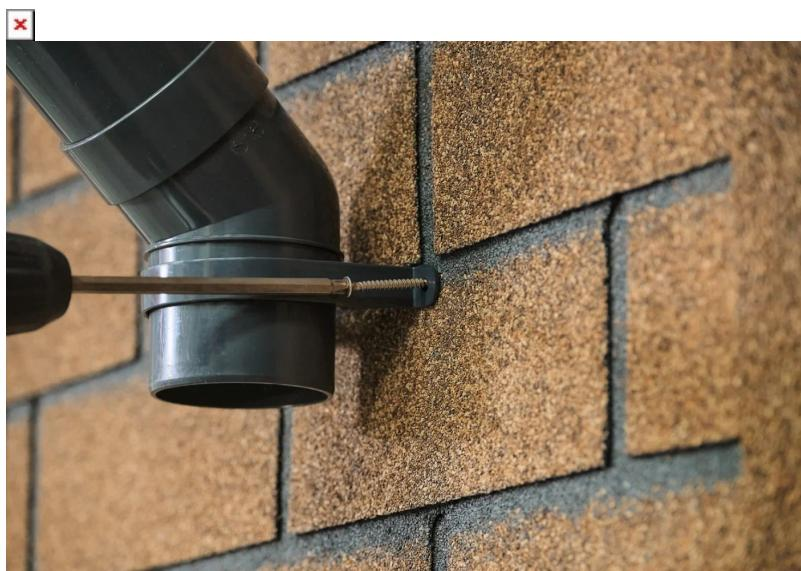
Хомуты с дюбелями фиксируются к фасадам в тех случаях, когда крепеж в основание устанавливается через дюбель, либо нужно отнести трубу на определенное расстояние от стены.
