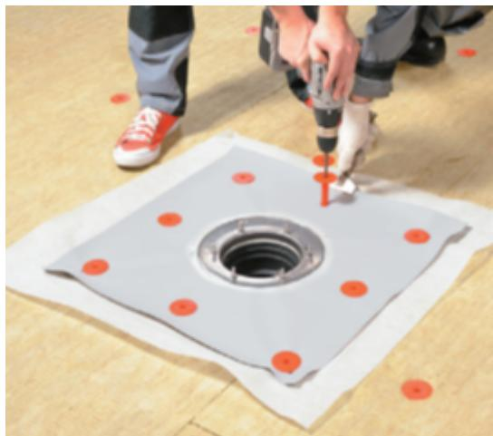
Продолжайте укладку мембраны в зоне установленной воронки обычным образом. После закрепления полотна найдите на мемbrane центр воронки как точку пересечения двух отрезков между гайками на фланце.
