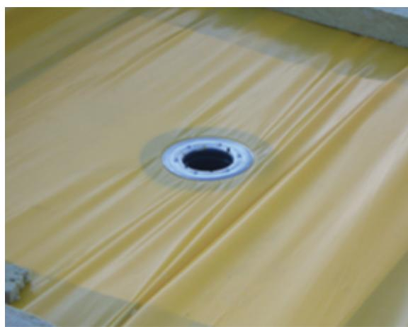
Для получения ровного твердого основания вокруг воронки, чтобы избежать проваливания воронки, используйте плиты XPS. Желательный размер такой площадки не менее **1x1 м.**
