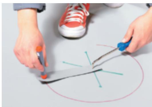
Разметку отверстия в мемbrane легко выполнить при помощи полоски мембраны и маркера. Используя приспособление как циркуль, нарисуйте окружность радиусом на **6 см** больше радиуса фланца.
