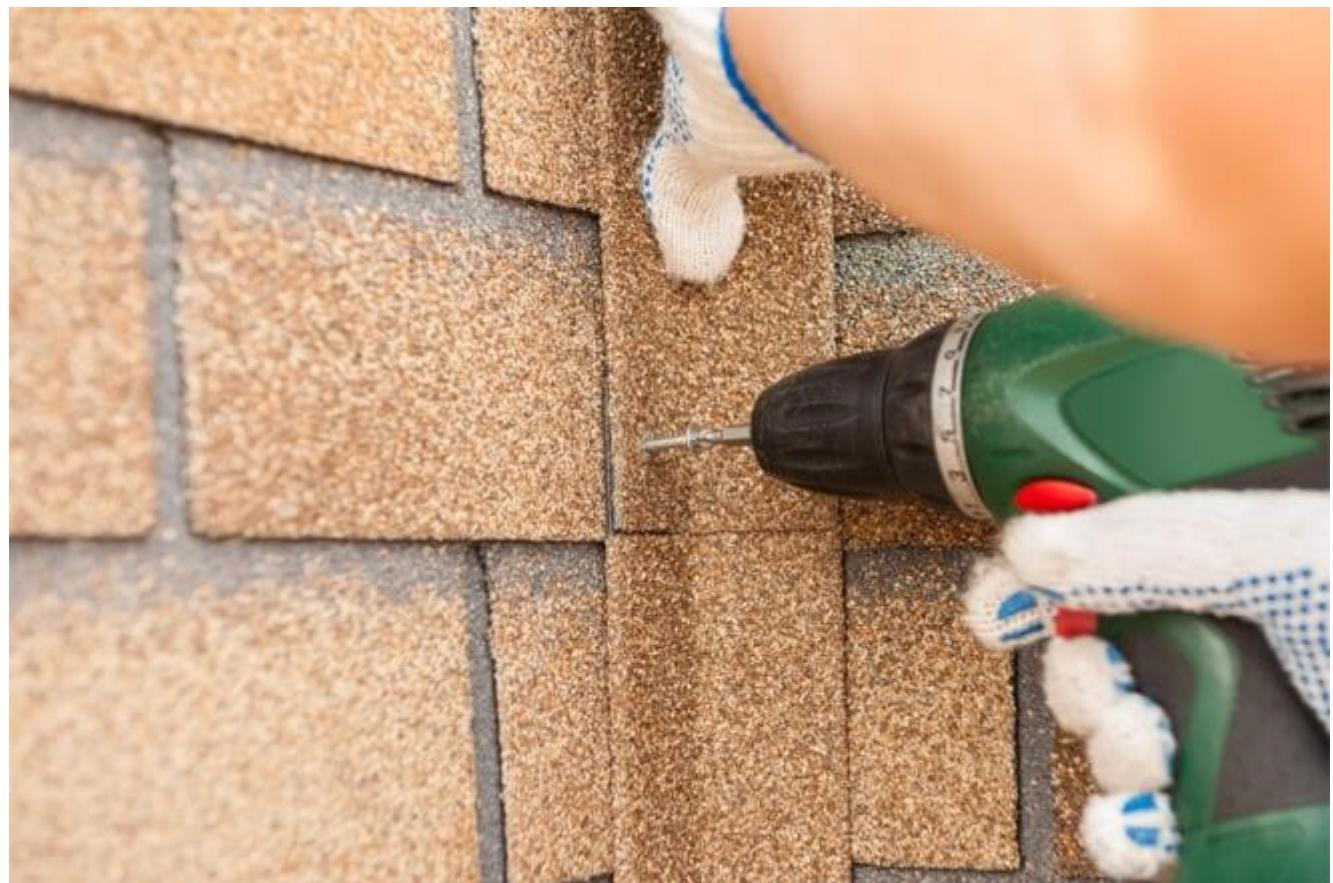
Рядовая плитка, выходящая на внутренний угол, подрезается так, чтобы расстояние от ее края до грани угла было 5–10 мм. При устройстве внутренних углов используются внутренние металлические уголки ТЕХНОНИКОЛЬ HAUBERK.
