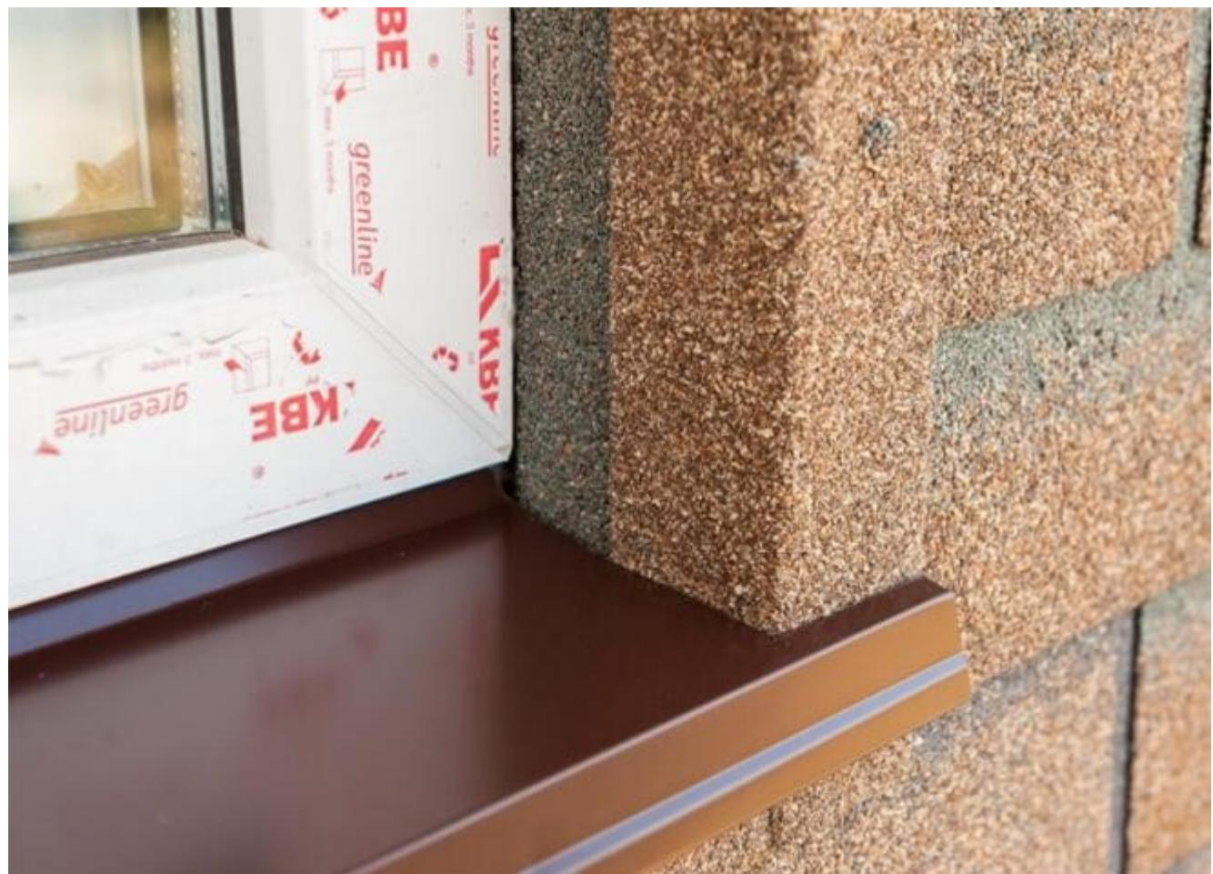
Часть рядовой плитки, выходящая в проем, подрезается с помощью кровельного ножа.
