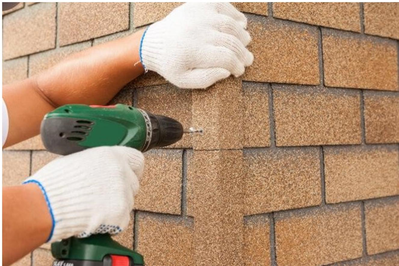
Рядовая плитка, выходящая на внешний угол, подрезается так, чтобы расстояние от ее края до грани угла было 5-10 мм. При устройстве внешних углов используются внешние металлические уголки ТЕХНОНИКОЛЬ HAUBERK.
