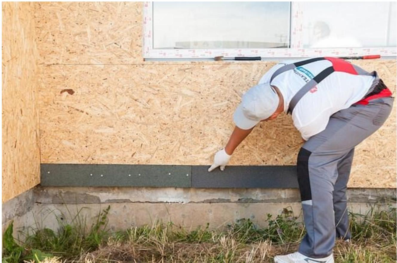
Для фиксации фасадной плитки HAUBERK применяют крепеж из оцинкованных гвоздей с широкой шляпкой.
