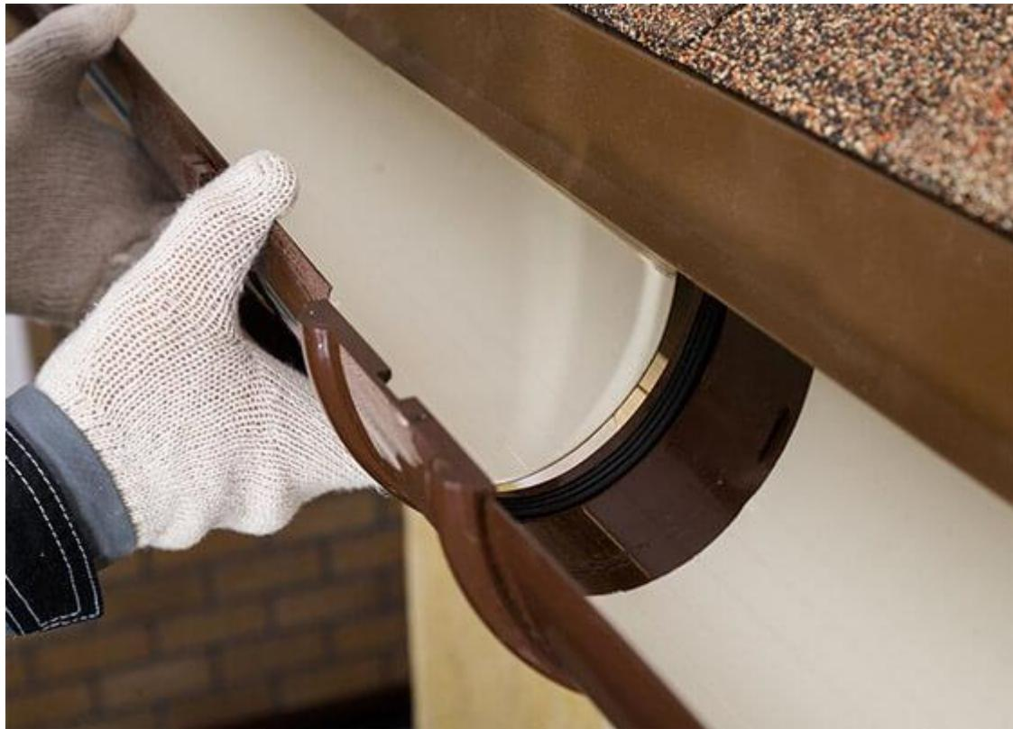
В случае расположения воронки на краю карниза, чтобы закрыть воронку заглушкой вам необходимо соединить воронку и заглушку отрезком из водосточного жёлоба. Распил жёлоба производите ножовкой с мелкими зубьями с последующей зачисткой среза напильником.
