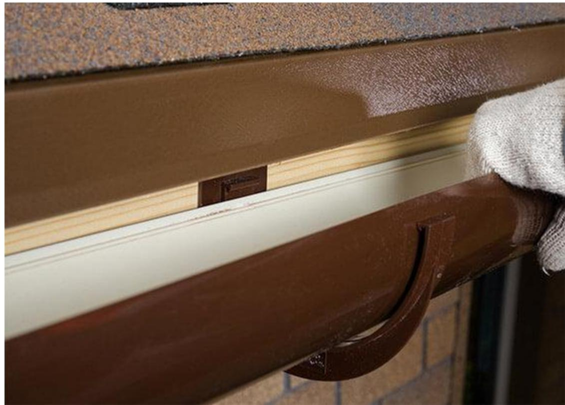
При необходимости соединить два жёлоба установите соединитель жёлоба. Ближайшие к соединителю кронштейны установите с каждой стороны элемента на расстоянии 100-150 мм. Вставьте жёлоб в соединитель жёлоба до обозначенной линии. Соединение жёлоба с кронштейном необходимо производить в направлении «изнутри-наружу».
