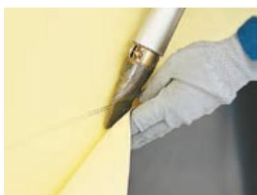
Сварите полотна автоматическим сварочным аппаратом. При движении аппарата вдоль нахлеста временное точечное крепление мембранны должно разрушаться.
