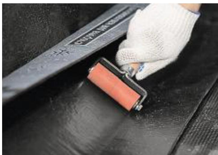
Одним из признаков качественного наплавления является вытекание битумной массы из-под боковой кромки материала сплошным валиком примерно на 5–25 мм.
