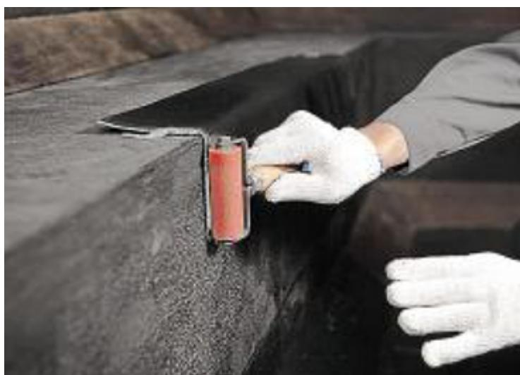
Наплавьте полосы усиления по всему периметру фундаментной плиты с обязательным
