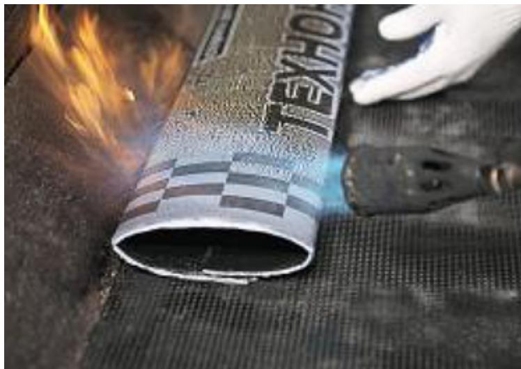
Затем наплавьте верхнюю часть элемента усиления на фундаментную плиту.
