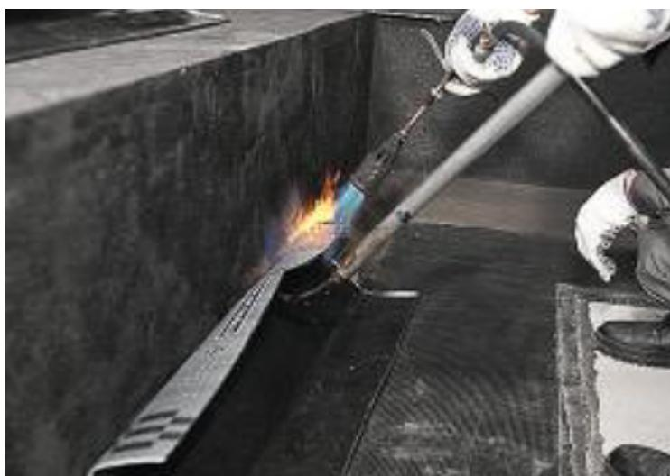
Завершите устройство полосы усиления, приплавив ее нижнюю часть к горизонтальной гидроизоляционной мембране.
