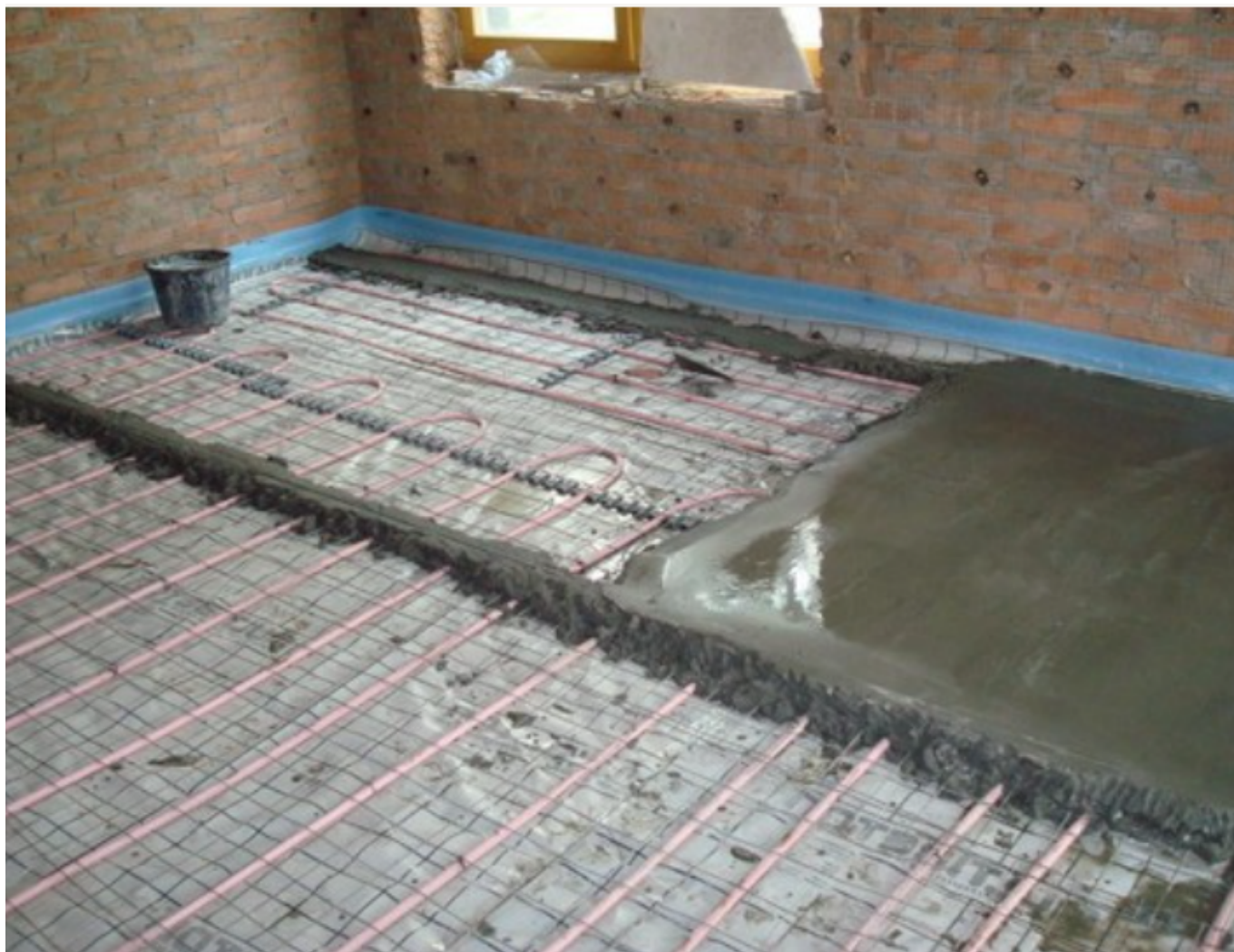
Пример утепления теплого водяного пола пенополистиролом
