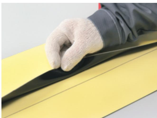
Ведите ролик параллельно срезу сопла, задавая амплитуду его движения, которая должна превышать ширину шва.
