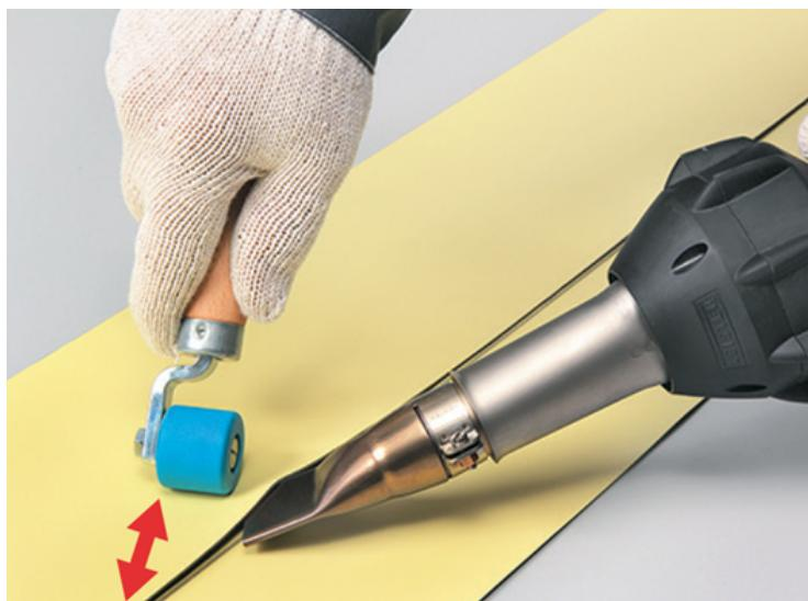
При этом ширина сварного шва (место гомогенного соединения двух слоев мембранны) должна составлять не менее 30 мм.
