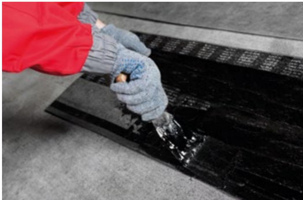
Коньково-карнизная черепица, выкройка из рядовой черепицы или рядовая черепица наклеиваются поверх подкладочного ковра с отступом от места перегиба карнизной планки 10-20 мм.
