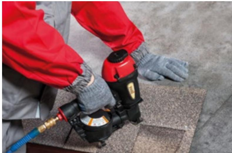
Коньково-карнизная черепица и выкройка из рядовой черепицы фиксируются кровельными гвоздями в количестве не менее 12 гвоздей на гонт. Рядовую черепицу фиксировать согласно схеме.
