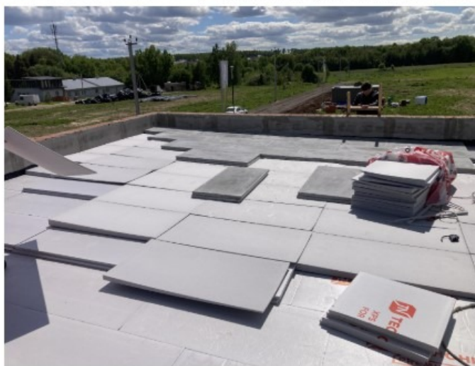
Укладка теплоизоляционных плит из экструзионного пенополистирола (XPS) на кровлю
