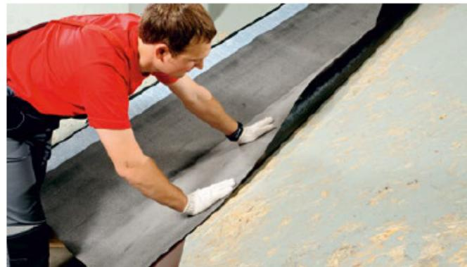
Пленка выполнена по всей плоскости подкладочного ковра. Ковёр, при монтаже полностью приклеивается к основанию и плёнка удаляется со всей поверхности.
