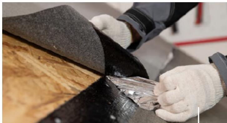
Плёнка выполнена только по плоскости, которая образует продольный перехлест на ширину 100 мм
