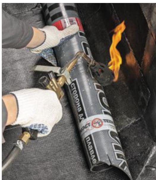
Наплавленный рулон должен выглядеть следующим образом:
