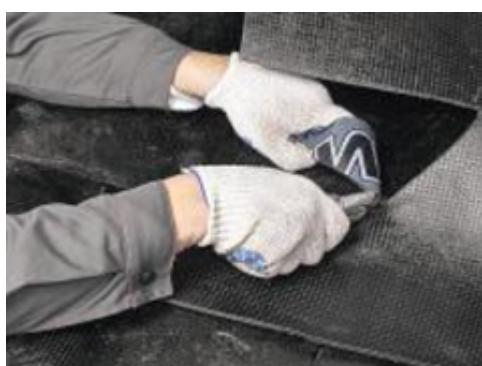
Отрежьте ненаплавленную часть рулона до уровня фундаментной плиты.
