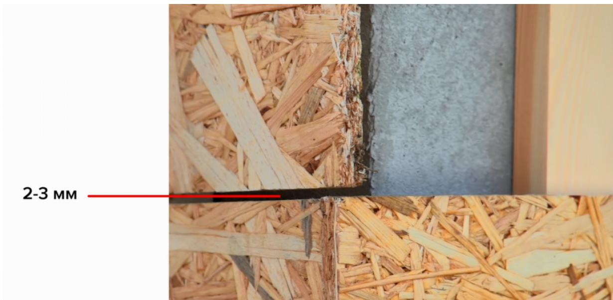
Для уменьшения риска повреждения фасадной плитки на углах оконных и дверных проемов (места концентрации напряжений) рекомендуется производить Г-образный распил плит ОСП-3.
