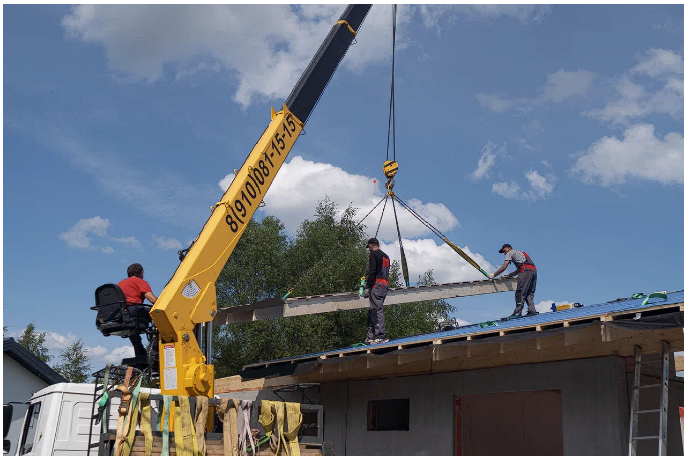
Рис.3. Монтаж кровельной панели при помощи специализированной техники
