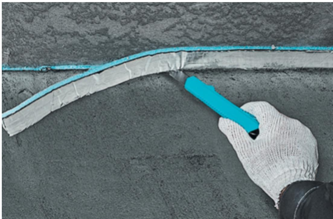
**ВАЖНО!** Очень важно обрезать демпферную ленту по уровню чистого пола, таким образом вы полностью отделите (изолируете) напольное покрытие от несущих стен.
