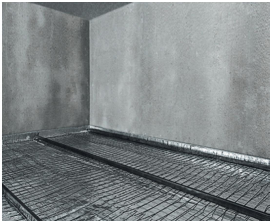
Высоту профиля рейки подберите равной толщине требуемой стяжки.
