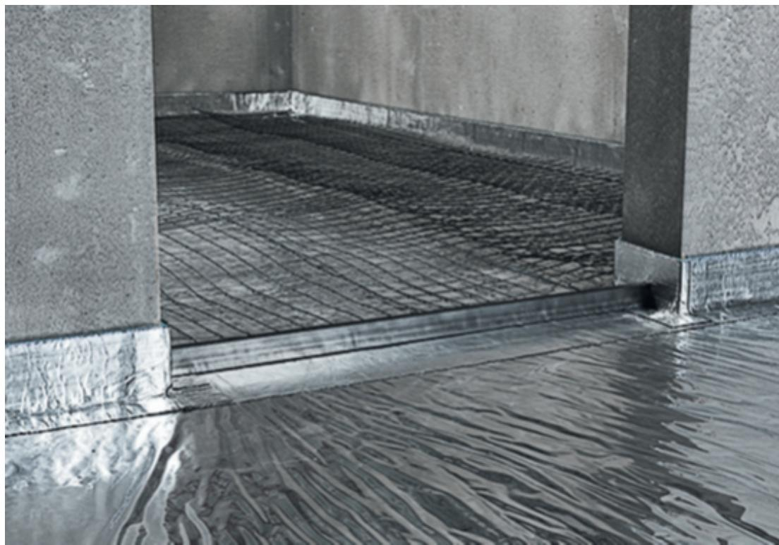
Температурными и деформационными швами по периметру стены служит установленная демпферная лента.
