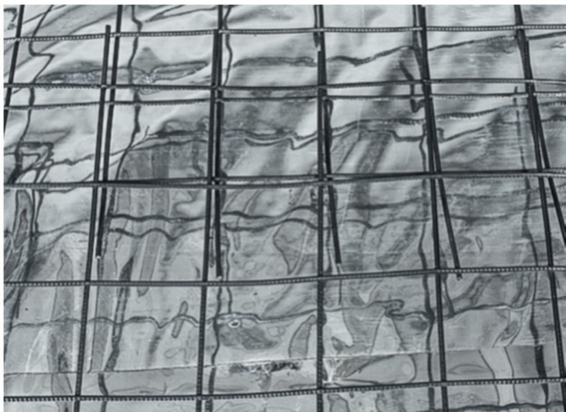
При устройстве теплового пола с помощью водяного отопления, трубопровод можно закрепить к уложенной армирующей сетке.
