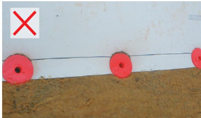
Установка крепежа близко к краю полотна может привести к разрыву мембранны в местах крепления под действием ветровых нагрузок.
