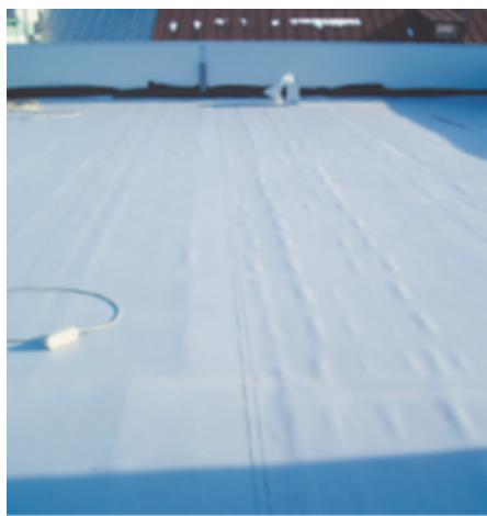
**ВАЖНО! Сила натяжения мембранны зависит от температуры на кровле. Не следует натягивать мембранны слишком сильно при температурах окружающего воздуха свыше +30°C, поскольку это может привести к появлению чрезмерных напряжений в мембранны при отрицательных температурах в зимнее время.**
