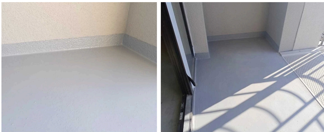
Фото 2. Система гидроизоляции ТН-ПОЛ ТАЙКОР Балкон на объекте.
