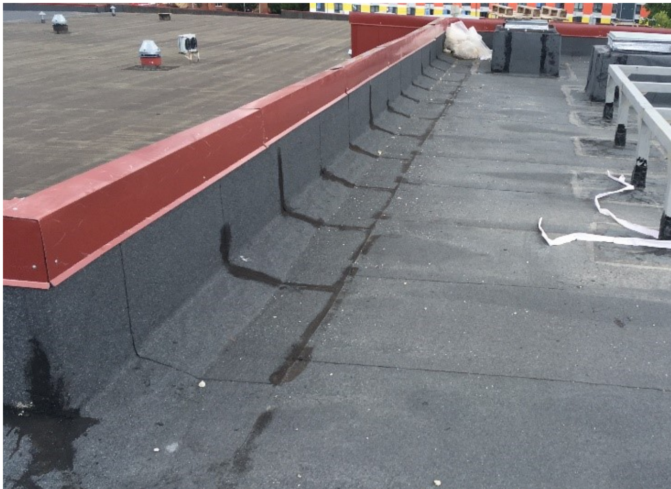
Протечки, отслоение гидроизоляционного слоя от основания
