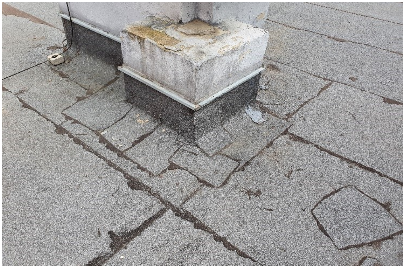
Нарушения герметичности узла, протечки
