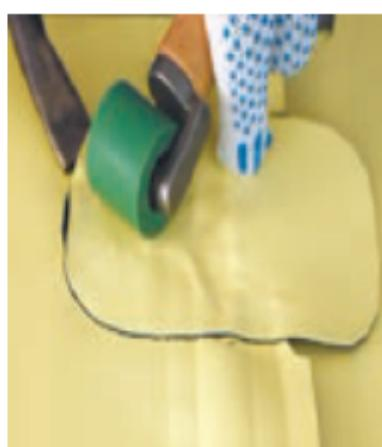
Заварите проверочный канал с противоположного «конца» шва и установите заплатку. После произведите проверку давлением воздуха.
