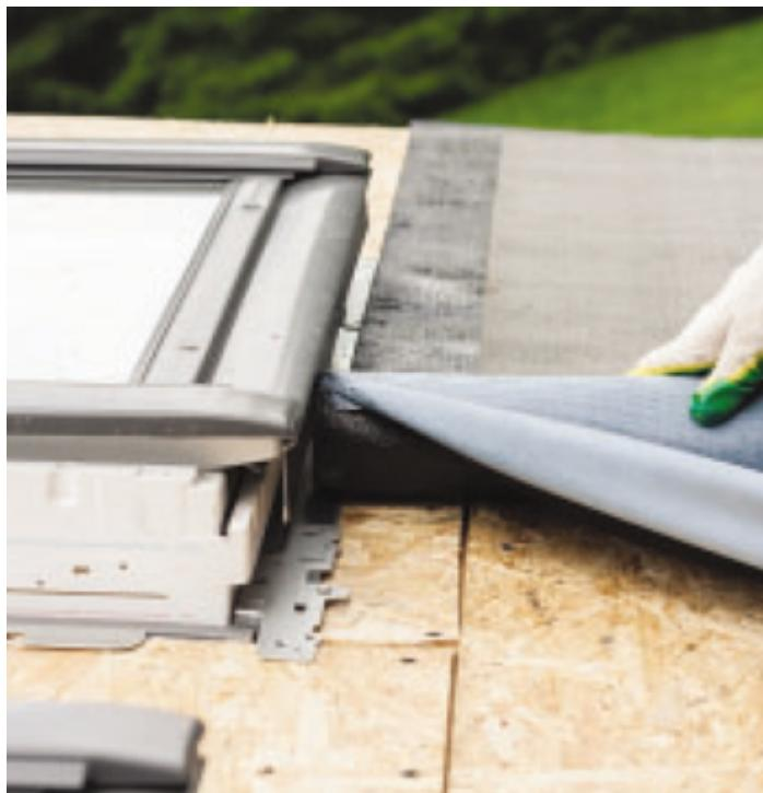
После монтажа изоляционных слоев, бруса для создания вентиляционного зазора и разреженной обрешетки наметить и вырезать проем мансардного окна.
