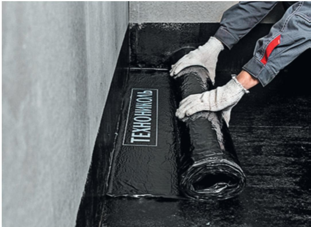
Для удобства приклейки материала на основание перекрытия вам понадобиться помощник: один человек вытягивает съемную пленку на себя и, таким образом, разматывает рулон, а второй – приглаживает материал с помощью щетки.
