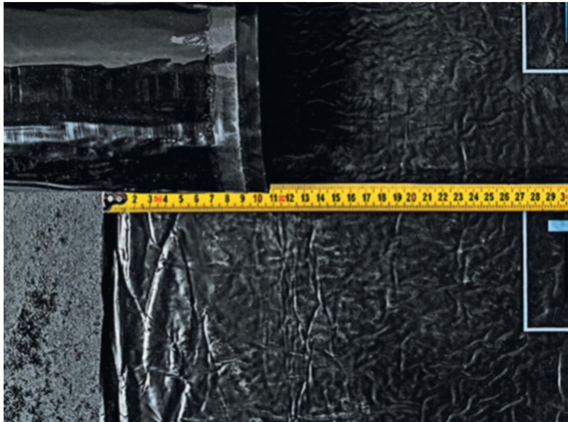
Торцевой нахлест смежных рулонаов должен составлять 150 мм.
