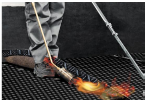
Сразу после сварки, пока не остыл материал, пройдитесь прикаточным роликом по сваренному шву для полной герметизации нахлеста.
