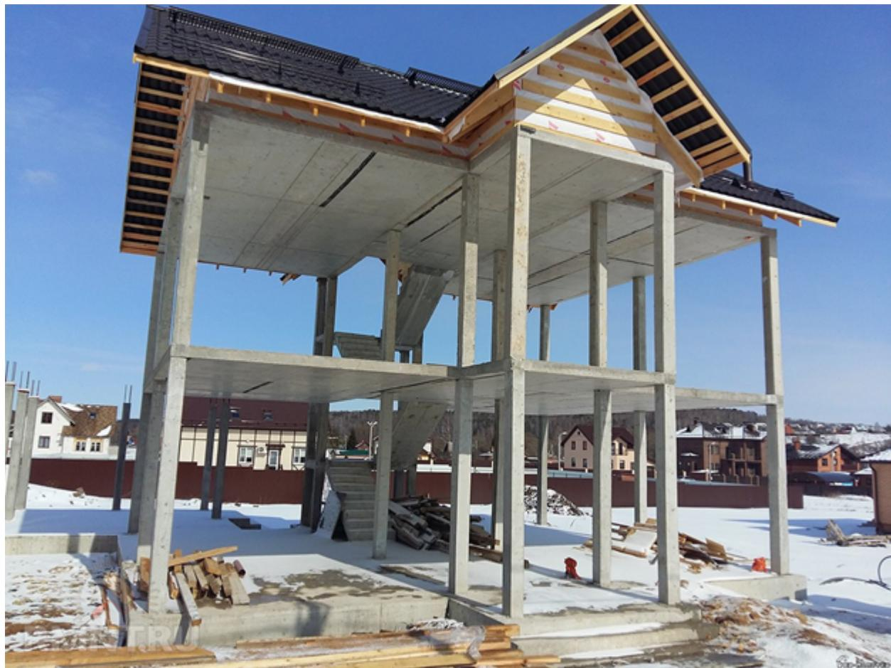
Безбалочные перекрытия – это конструкция, выполненная из сплошной плиты, которая имеет опоры на колонны. Они конструктивно могут быть с капителями и без них.
