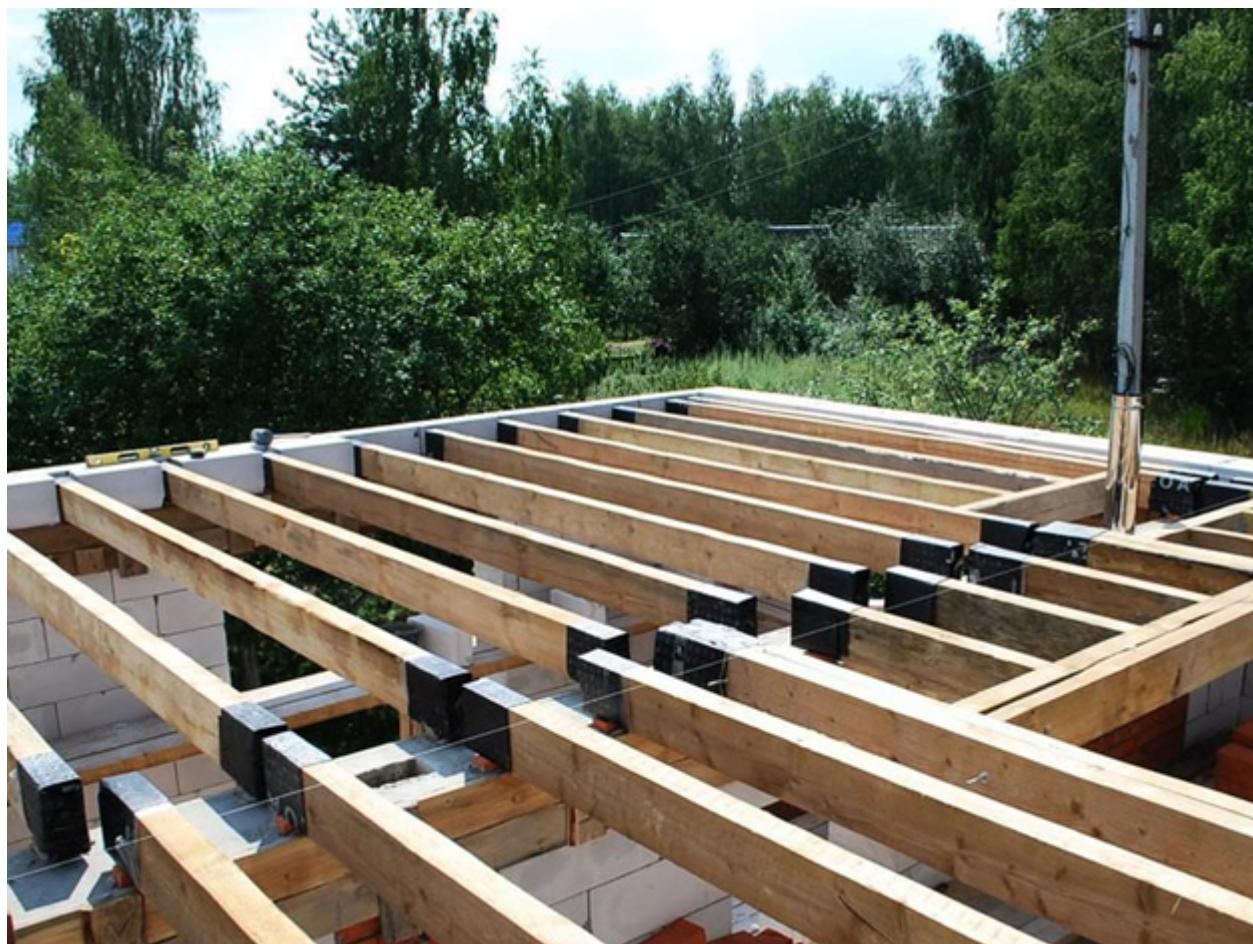
Перекрытия по деревянным балкам организовывают в малоэтажных каменных и деревянных строениях. Такие перекрытия удобны для индивидуальных застройщиков. В качестве несущих элементов используют балки из хвойных пород.
