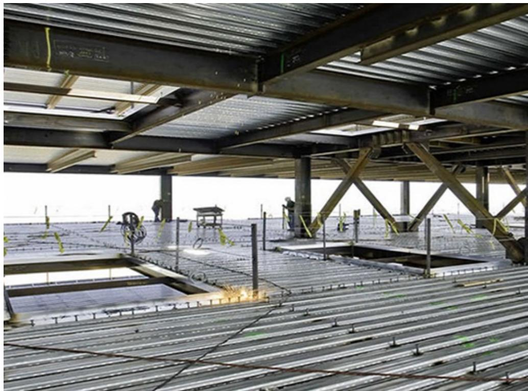
Металлические перекрытия используются для промышленных и жилых сооружений, общественных и административных зданий. Такие конструкции отличаются высокой прочностью и надежностью, малым весом и высокой скоростью монтажа.
