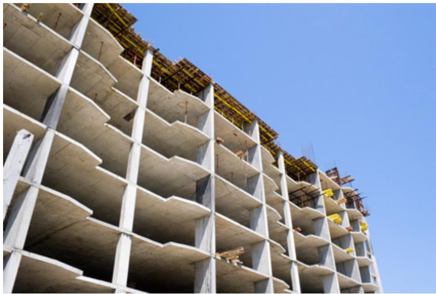
Железобетонные перекрытия являются одним из самых прочных и огнеупорных перекрытием. Железобетонные монолитные или сборные перекрытия применяются при строительстве домов из камня, кирпича в два и более этажа.
